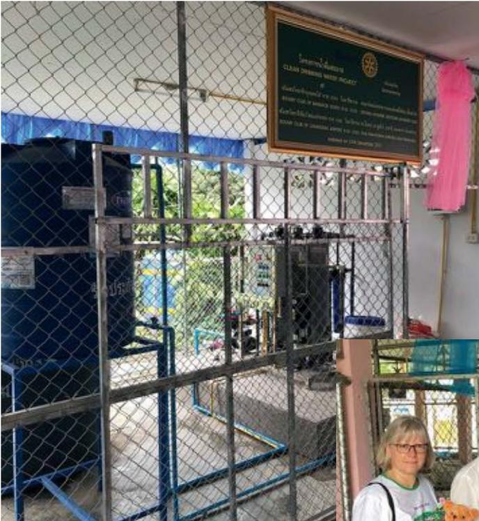
Die Anlagen (hier die Hom Tor School in Li, Narkhonping) mit ihren Reinigungsfiltern und Vorfiltern werden individuell nach Qualität des Rohwassers vom Hersteller zusammengestellt. Mit Druck wird das Wasser über Nacht durch Reosmosefilter und Kunststofffilter gedrückt und in einem Auffangbehälter gesammelt. Von dort läuft es zu der benachbarten Zapfstelle.
