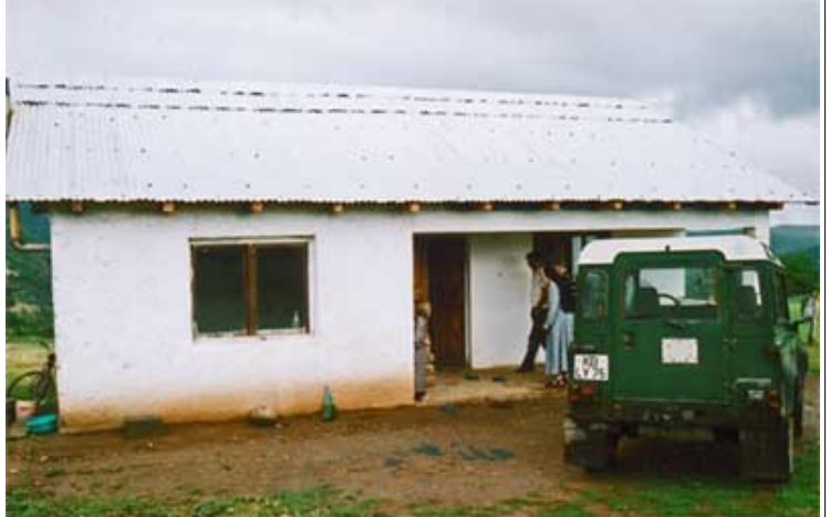
Eines unserer neu erbauten Häuser
