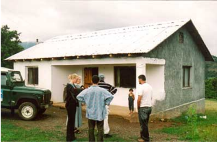
Eines unserer neu erbauten Häuser
